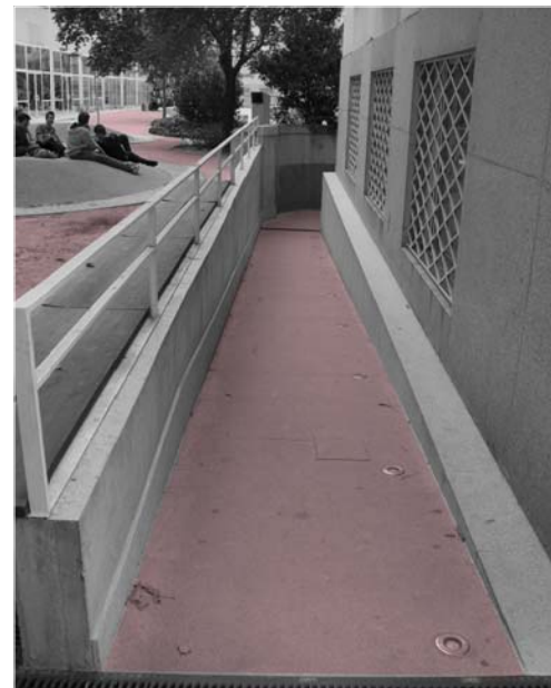
Rampa de conexión con acceso nivel X
